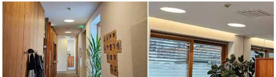
Im Büro wurden alle Leuchtmittel getauscht.
